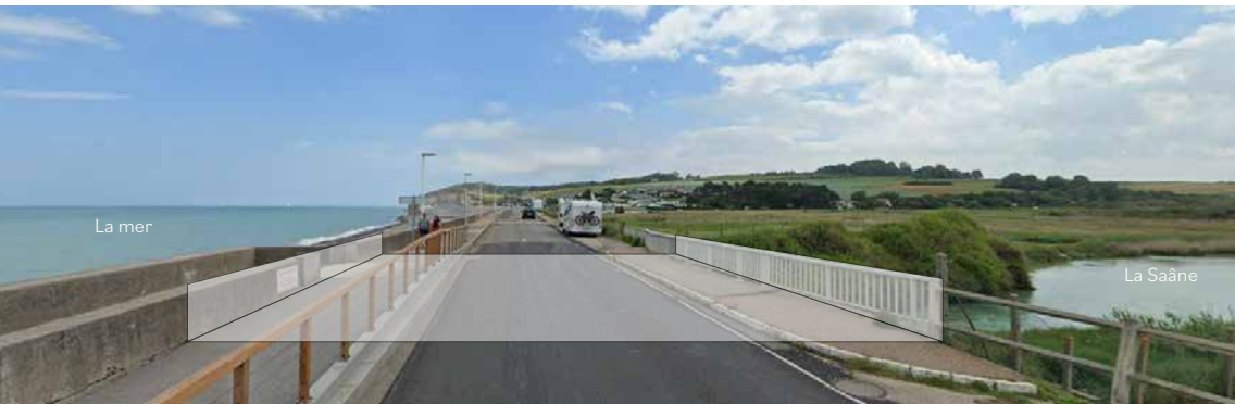
Digue-route qui sera ouverte sur 10 mètres pour permettre au fleuve de rejoindre la mer plus facilement et à la mer de pénétrer dans les terres pendant les grandes marées © Crédit illustration : Google street view, CAUE 14
