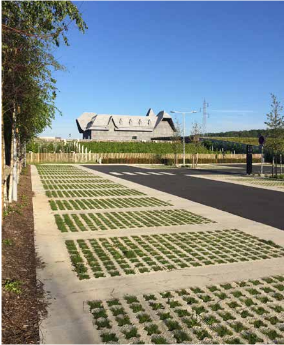
Aire de stationnement perméable, parking Honfleur Normandy Outlet © Crédit photo : CAUE 72
