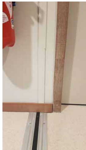
Champlat sur joint parasismique à droite © Crédits photos : CAUE 14
