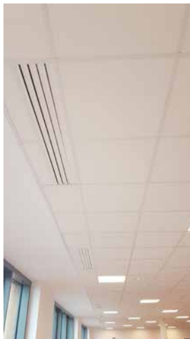
Grille d'extraction de l'air intérieur au niveau du plafond © Crédits photos : CAUE 14
