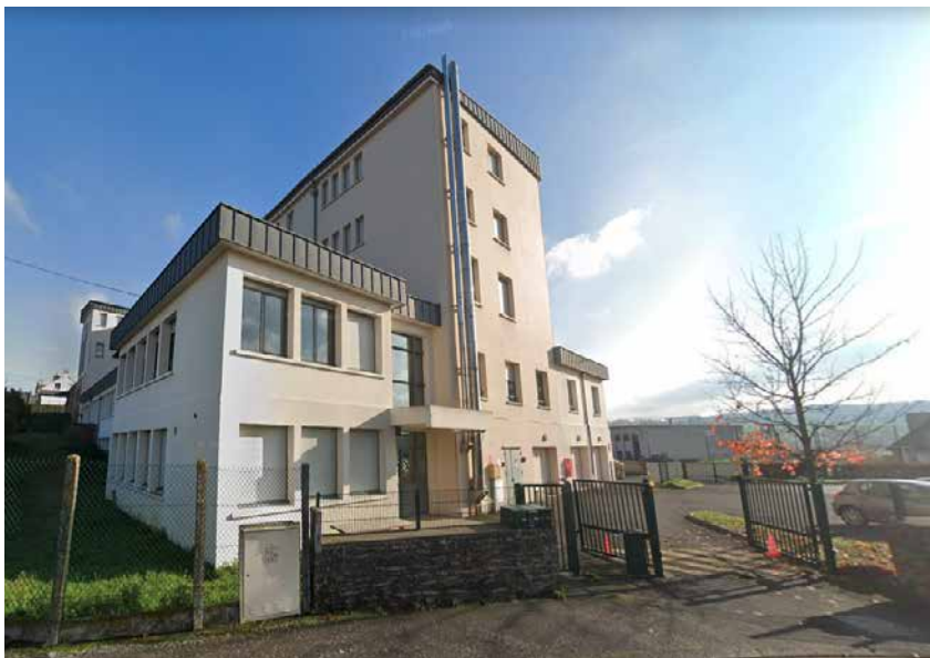
Sortie des gaines de la double-flux sur le pignon de l'école © Google Street view
