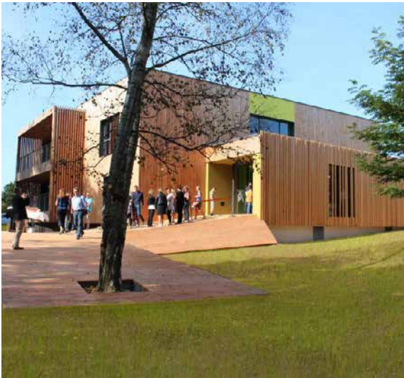
La rampe d'accès dessert l'ensemble du projet. Elle est partiellement fermée en cas d'alerte inondation. © Crédit photo : agence Normier + Postec
