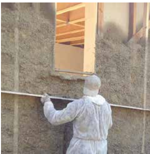
Pose de lin en vrac / Pose de lin en panneaux agglomérés souples © maison-travaux.fr et eco-logis.com
