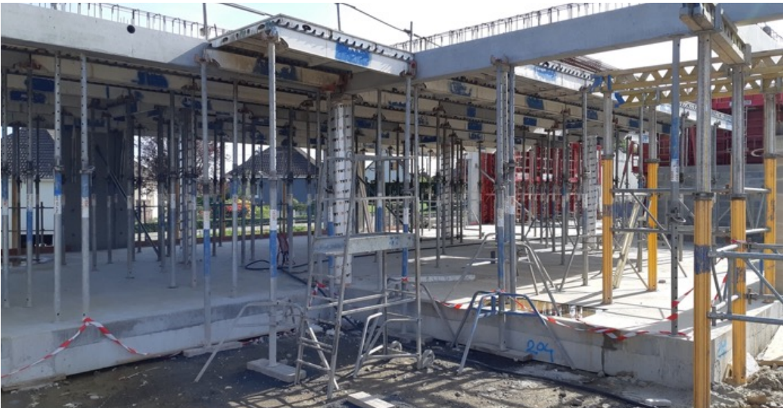
Solidarisation entre la dalle portée et les fondations du rez-de-chaussée, assurant une protection contre le radon © Crédits photos : BETOM Ingénierie
