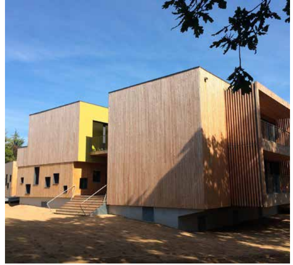
Le vide sanitaire ouvert en béton laisse circuler l'eau sous le rez-de-chaussée en cas d'inondation. © Crédit photo : agence Normier + Postec
