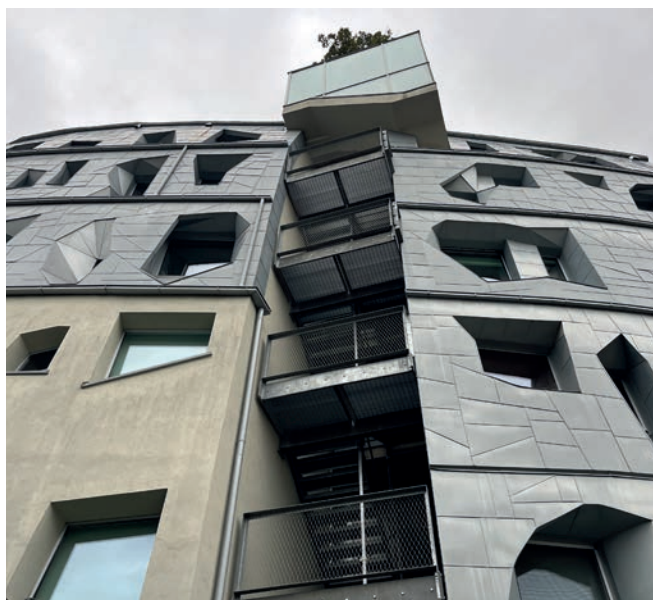
La façade intérieure de l'immeuble au nord en matériaux isolants, d'une épaisseur de 60 à 120 cm, avec des ouvertures irrégulières et des menuiseries faites sur mesure. Le haut pouvoir isolant de la façade garantit l'accumulation de chaleur dégagée en hiver. Cette façade est recouverte de plaques de zinc-titane qui la protègent et qui ont été réalisées sur place. photo © 2024 CAUE 14
