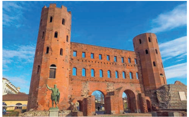
La Porta Palatina reste visible avec ses deux tours à 16 côtés pour dévier les projectiles des catapultes et ses 4 ouvertures, larges pour les chars et étroites pour les piétons. Un vestige de l'enceinte est également visible, à droite. Elle est composée d'un conglomérat de chaux et de cailloux du fleuve, avec des rangées de briques intercalées. photo © VisitItaly
