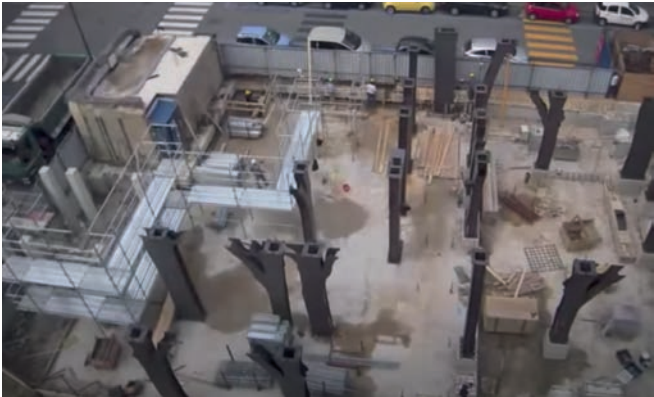
Les superstructures en acier corten en forme d'arbre soutenant les terrasses et récupérant les eaux de pluie. photo © LineeVerdi
