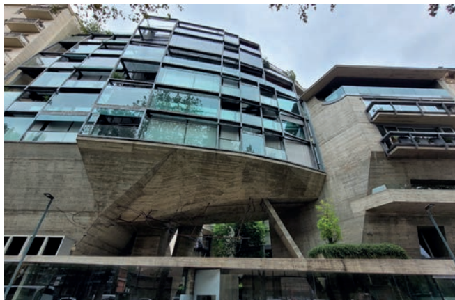
La façade sud sur le boulevard avec sa double peau de verre protégeant du bruit, et son imposante structure inférieure en béton armé, accumulant la chaleur du soleil en hiver et évitant la dispersion de la chaleur interne vers l'extérieur (inertie thermique). Grâce à la double courbure, le premier volume (celui qui est contigu à un bâtiment datant des années 1950, à gauche) passe de 10 à 6 étages, soit la hauteur du deuxième volume (celui qui est contigu à un bâtiment du XIX e siècle, à droite) photo © 2024 Aucame
