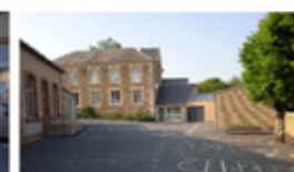
Vue vers la Murie, la salle des professeurs, salle de rangements, sanitaires, bibliothèque
