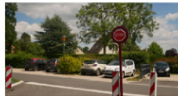
Sortie nouvelle voie d'accès à l'école
