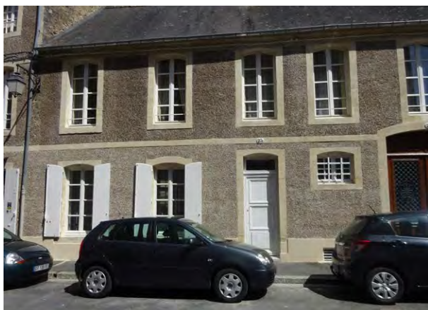
Après les travaux
