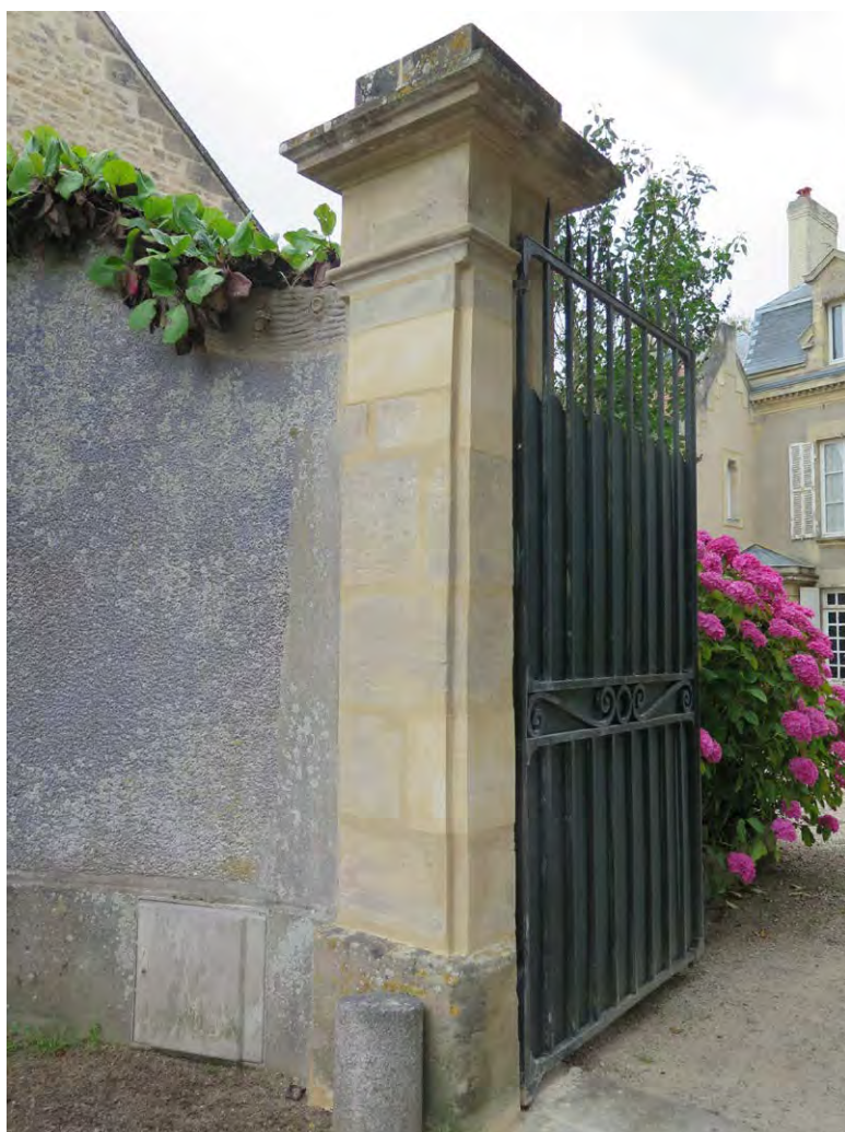
Après les travaux
