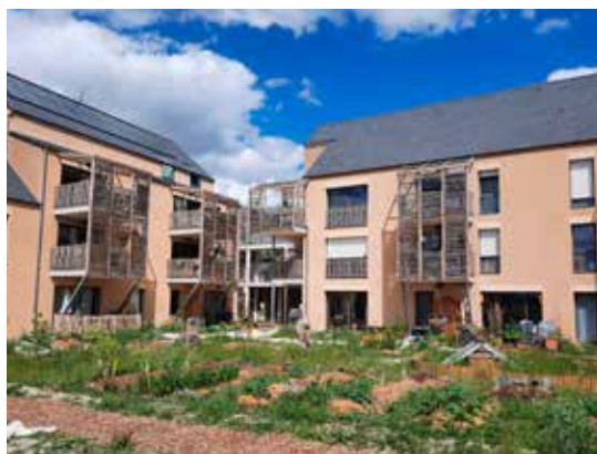
L'Ôdôberge à Dol-de-Bretagne, résidence participative écologique avec un bailleur social comme maître d'ouvrage
