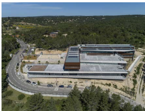
Un bâtiment bioclimatique à énergie positive Pôle éducatif Mas de Teste à Nîmes (30)
