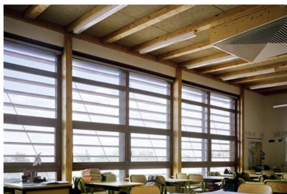
Exemple de dispositif d'ombrage extérieur amovible École Primaire Vancia à Rillieux la Pape (69) Agence d'Architecture Tekhnè Architectes & Urbanistes © Crédit photos : Jean Christophe Galmiche & Renaud Araud
