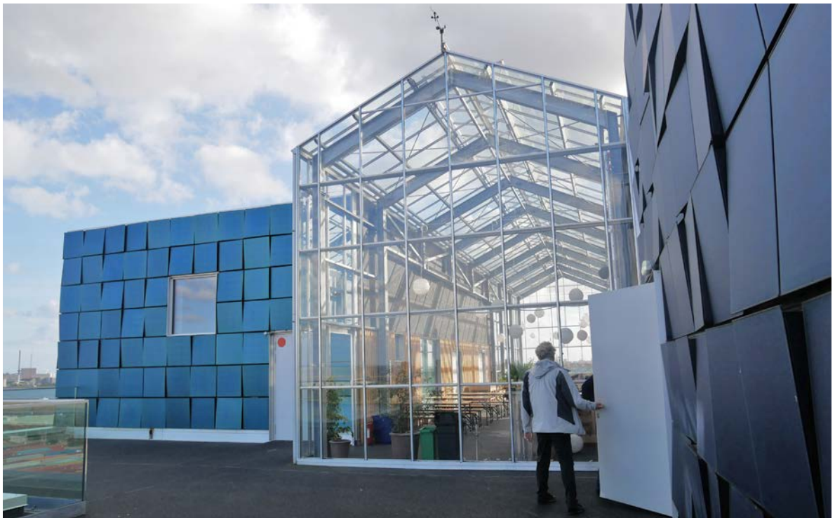
Les cellules solaires "écailles de poisson" sur les façades des blocs scolaires et une des serres, École Internationale de Copenhague. Agence d'Architecture C.F. Møller Architects © Crédit photo : CAUE du Calvados
