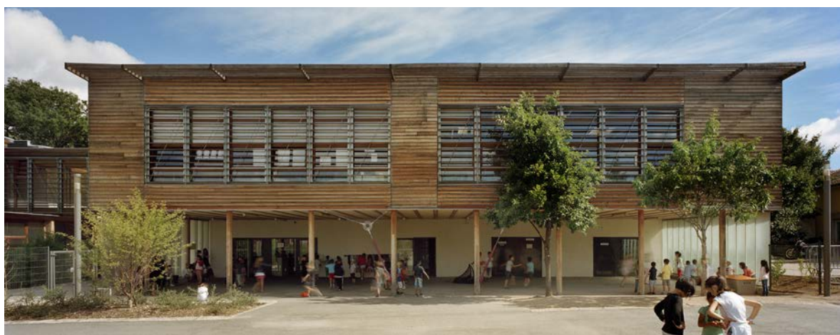
Exemple de dispositif d'ombrage extérieur amovible École Primaire Vancia à Rillieux la Pape (69) Agence d'Architecture Tekhnè Architectes & Urbanistes © Crédit photos : Jean Christophe Galmiche & Renaud Araud
