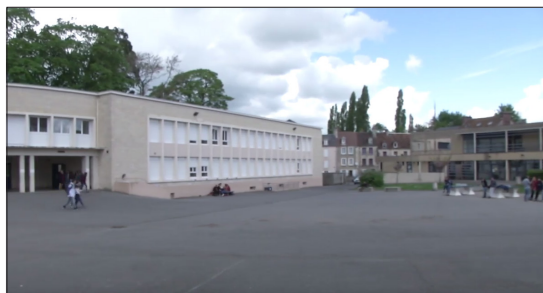
Cour du collège existante
