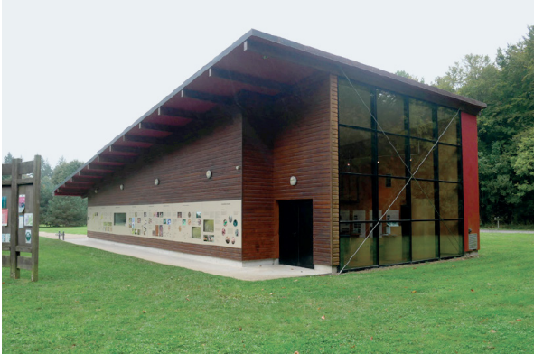
LA FAÇADE DE L'EXISTANT
