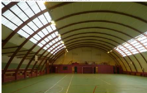
Vue de l'intérieur de la salle
