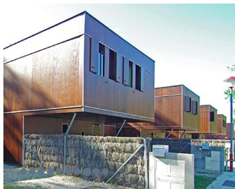
Contraste de matière entre clôture en brande de bruyère naturelle et muret technique maçonné
