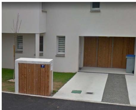
Porte cache coffret dissimulant les éléments techniques et adressage intégré
