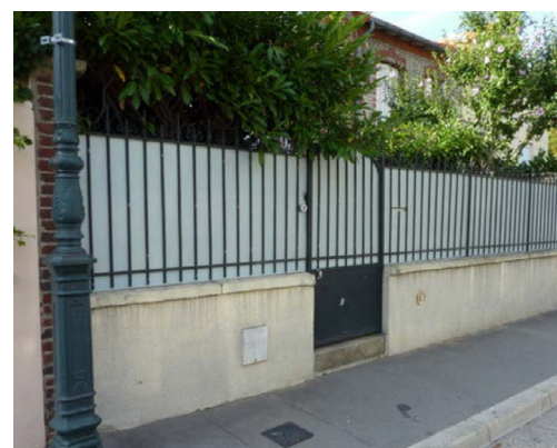
Canisse partielle peu esthétique remplacée par une plaque occultante sans embouts posée à l'intérieur du barreaudage métallique, mais contraste important avec la couleur foncée de la grille. La multiplication de teintes et de matériaux rend plus problématique l'intégration de la clôture.
