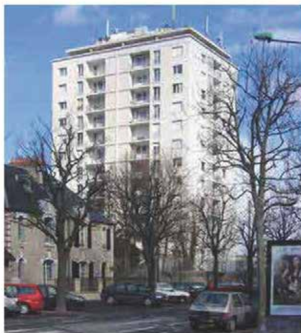
La tour HLM de l'opération « Entrée de ville » à Caen, architectes M. Brillaud de Laujardière et M. Lizeou, 214 rue d'Auge
