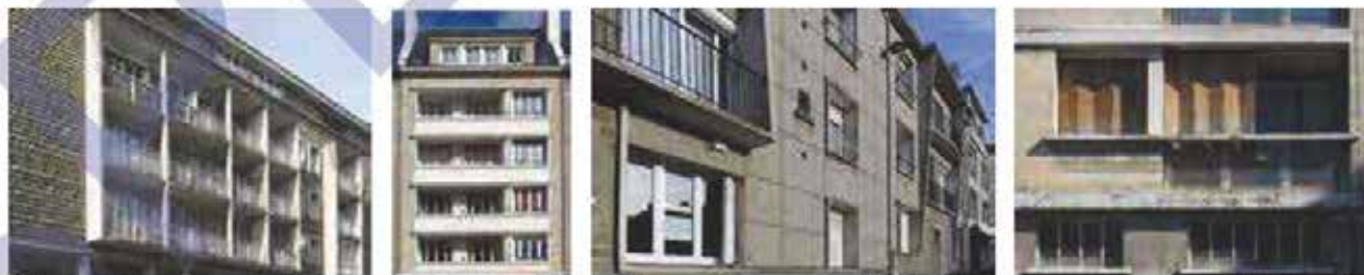
Balcons et loggias : Lisieux, rue du Pont-Mortain ; Caen, rue Saint-Jean ; Vire, rue Girard architecte J.L. Humbaire ; Caen, groupe Saint-Jean-sud architecte chef de groupe M. Clot
