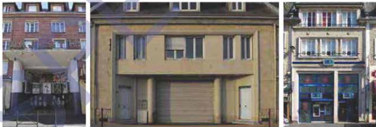
La monumentalisation du commerce : Lisieux, cinéma Majestic, rue du Char ; Sannerville, ancien garage ; Isigny, banque sur la place de Gaulle
