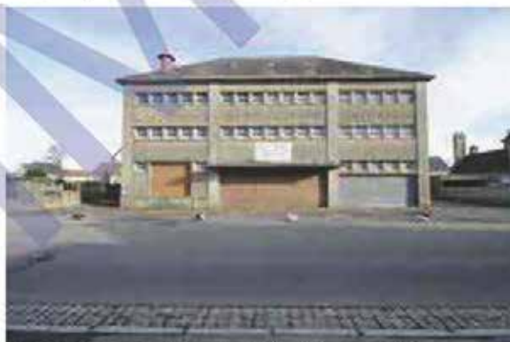
Ancien bâtiment industriel route de Villers à Aunay-sur-Odon
