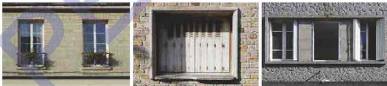
Le traitement des fenêtres : ouverture à angles vifs (Villers-Bocage), encadrement saillant (Condé-sur-Noirau), encadrement de plusieurs baies (Vire)
