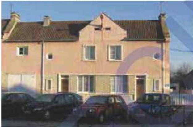
Immeuble jumelé à Eproni, place de la mairie, architecte J. Maître
