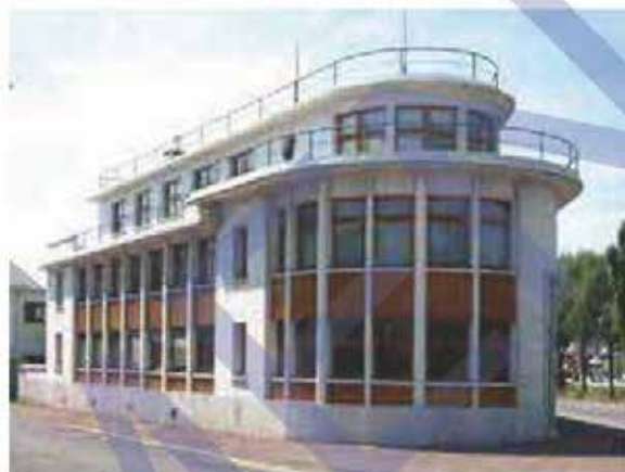
Caen, le siège de la Navale caennaise, architectes L. et O. Sire
