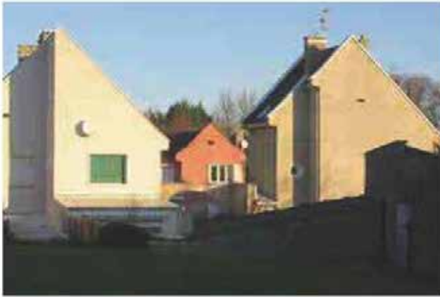
Eproni, vue générale, architecte J. Maître
