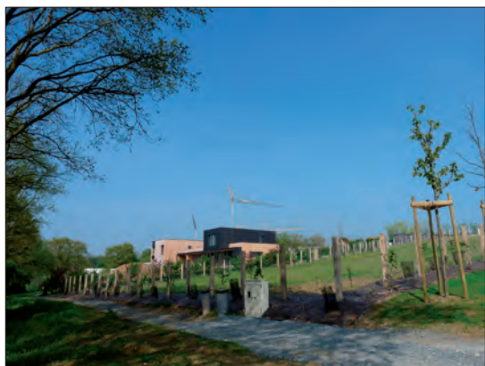
Construire dans la pente - Loire Atlantique
