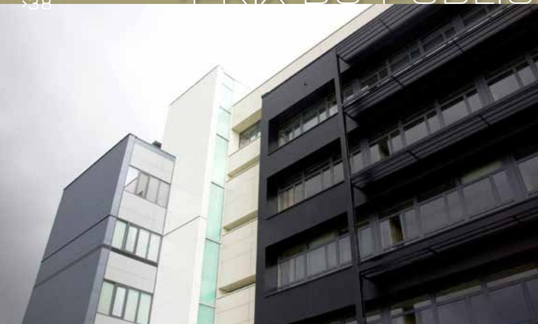
extérieures. Les châssis vitrés ont été remplacés par des châssis en aluminium à faible émission de teinte grise, et l'intégralité des façades a été revêtu d'un isolant en laine minérale, recouverte par une vêtue. Ce système a permis de redessiner la façade, tout en offrant des améliorations thermiques conséquentes.
