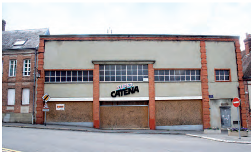
bâtiment avant restructuration
