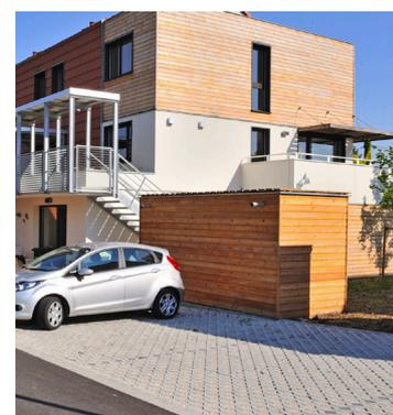
Réduction de l'imperméabilisation des sols avec bandes de roulement en béton désactivé et bandes enherbées centrales, pavés en béton à joints enherbés, ou encore dalles alvéolées en béton avec graviers stabilisés
