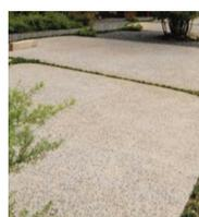
Béton désactivé et joints enherbés
