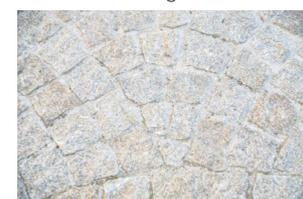
Pavage avec pose et joints en sable
