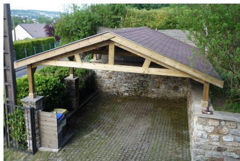
Carports indépendants à double ou monopente en structure métallique ou bois posée sur pilastres et muret en pierre
