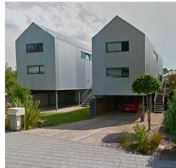
Principe du carport avec espace couvert créé grâce à la surélévation de la maison sur pilotis
