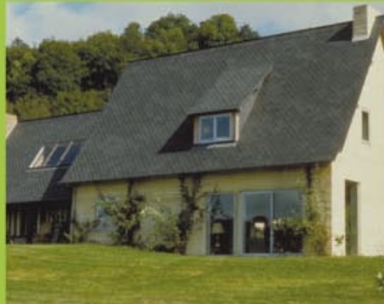
» Architecte : Antoine Berge Photo : CAUR 14
