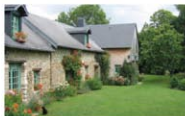
» Entreprise : Jouanne-Lefèvre Photo : CAUE 50
