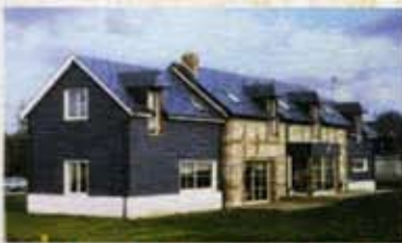
archt. B. Bonhaume - ent. Charpentiers d'Aujourd'hui
