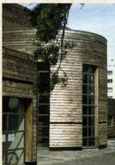
Collège d'Hérouville-Saint-Clair archi. R. Castro - ent. Belliard et Pommier
