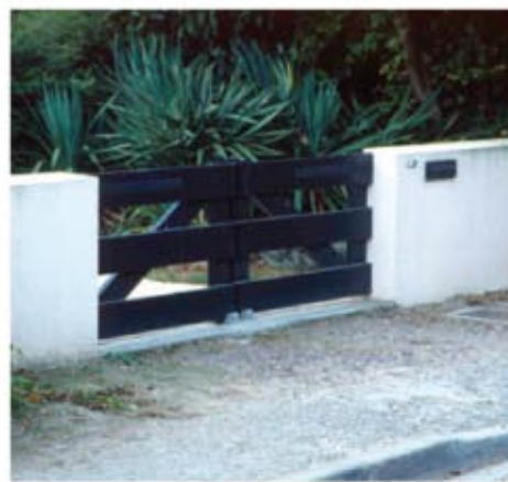
» Muret maçonné et portail en bois
