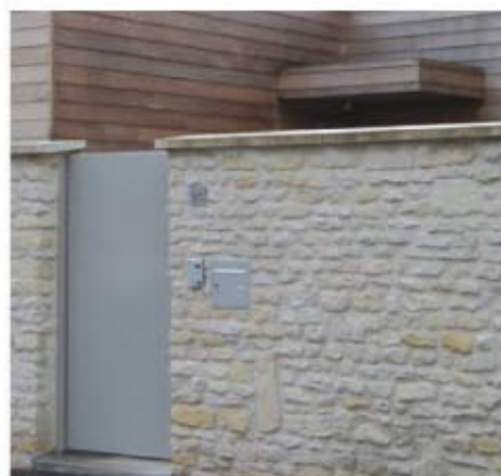
» Portillon dans muret maçonné
