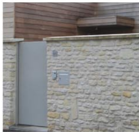
» Portillon dans muret maçonné
