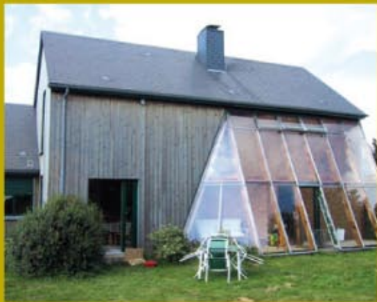
» Entreprise : Eugène Azzopardi Photo : CAUE 61
