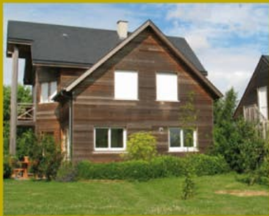
» Architecte : Jean-Jacques Poupard Photo : CAUE 50
